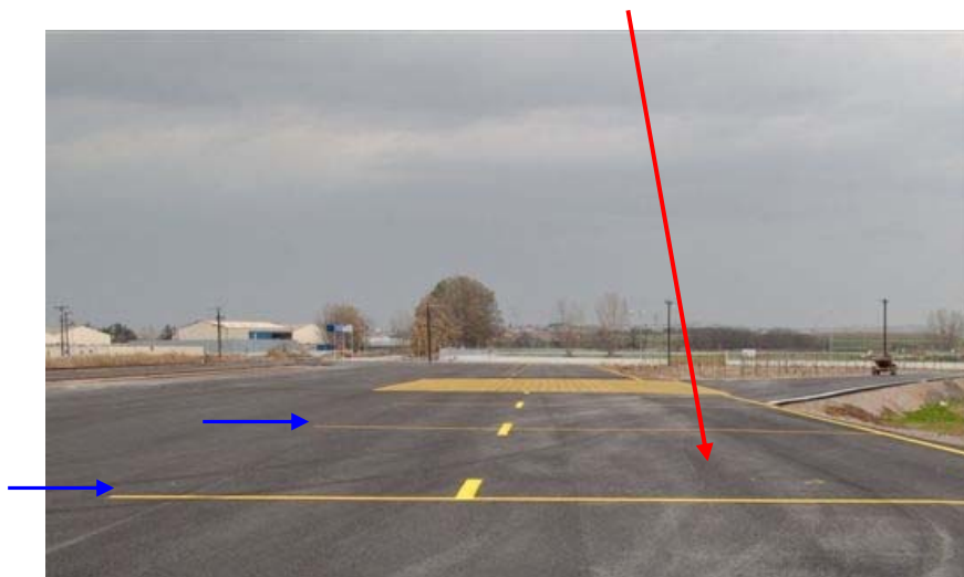
Φωτογραφία 5: Χώρος εναπόθεσης container
