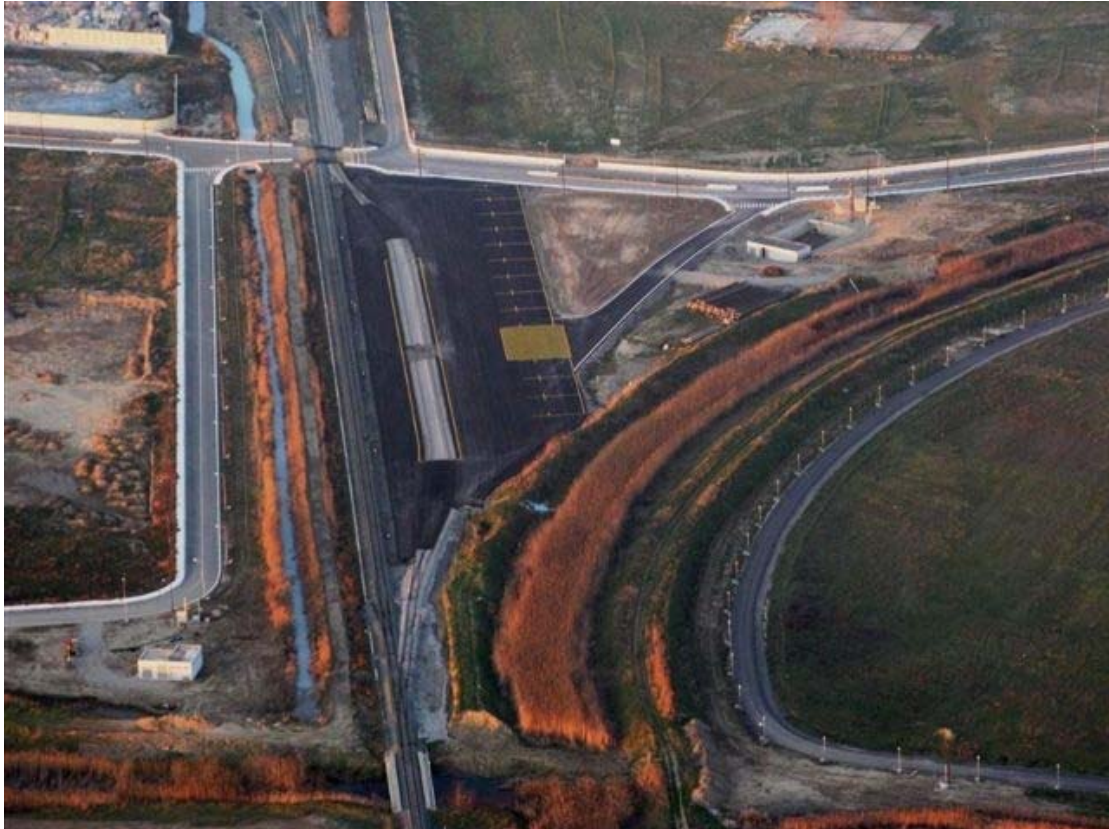
Φωτογραφία 2 : Αεροφωτογραφία σιδηροδρομικού σταθμού
